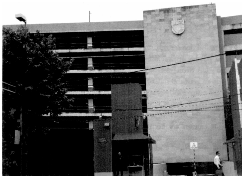
Figura 4. Edificio de estacionamiento de la UP. Fuente: Susana Quiroz, noviembre, 2014.
